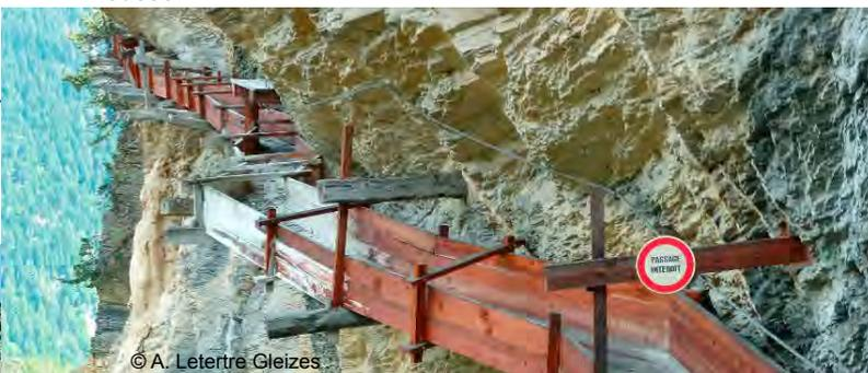
Les matériaux de construction ont évolué : les pierres, le bois et la terre ont été supplantés par des métaux pour fixer les chenaux aux falaises et des tuyaux en béton, en métal (« auges ») ou en matériaux synthétiques qui facilitent le soutien du bisse et permettent de lutter contre l'érosion et la perte d'eau.
